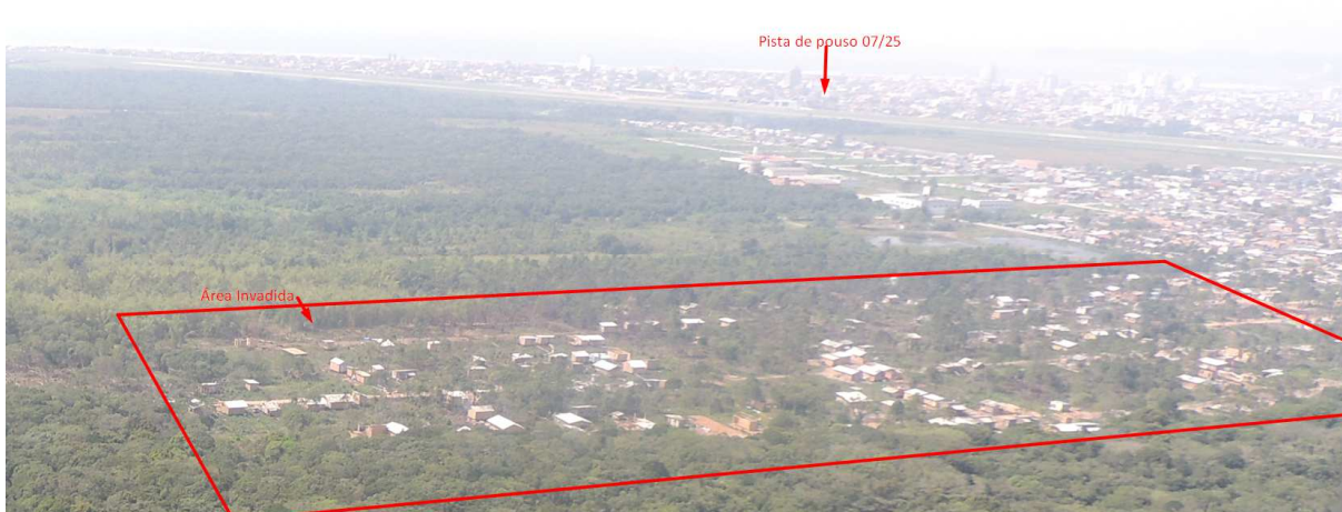
Figura 12 - Invasão de área de expansão do sítio aeroportuário, comunidades Nova Canaã e Monte Sião, alvo de reintegração e posse ocorrida no ano de 2018
